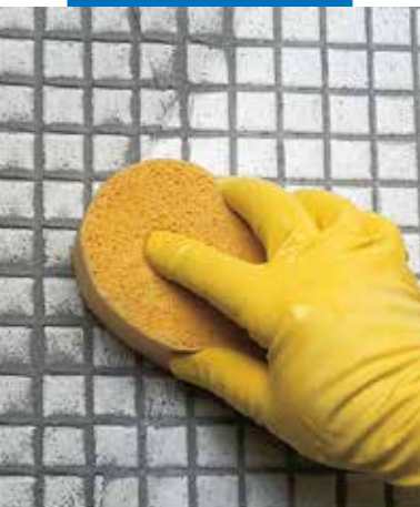
Üvegmozaik tisztítása szivaccsal
