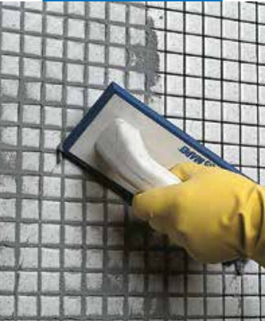
Üvegmozaik (fürdőszoba) fugázása simítóval
