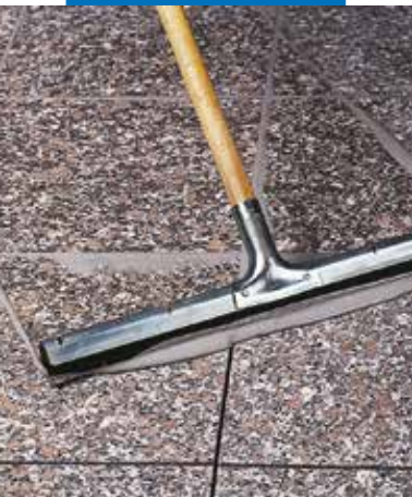
Előcsiszolt és fényezett gránitpadló fugázása gumilehúzóval
