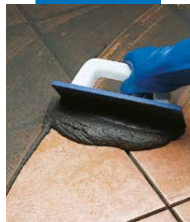
Egyszer-égetett burkolólap fugázása simítóval
